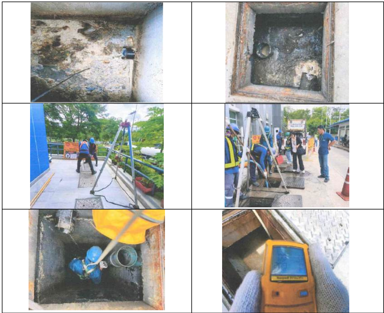
รูปที่ 2-11 การตรวจสอบบ่อดักไขมัน
