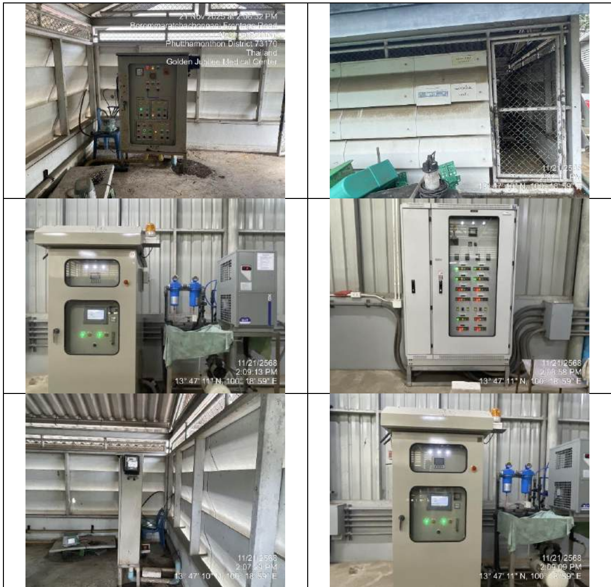
รูปที่ 2-12 การติดตั้งมิเตอร์ไฟฟ้าของระบบบำบัดน้ำเสียและการควบคุมการทำงานของระบบบำบัดน้ำเสีย
