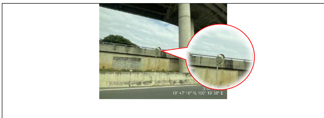
รูปที่ 2-20 การติดตั้งกระจกนูนบริเวณมุมอับทางถนนพุทธมณฑลสาย 4
